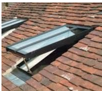
Exemple de fenêtre de toit de type tabatière
