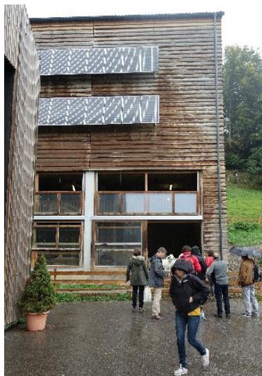
Dans le cas des allèges, traiter les capteurs comme un seul élément avec la fenêtre ;
