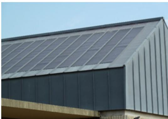
Choisir des capteurs « souples » et privilégier un bac acier dans les tons de gris pour une meilleure intégration avec la couleur des capteurs.
